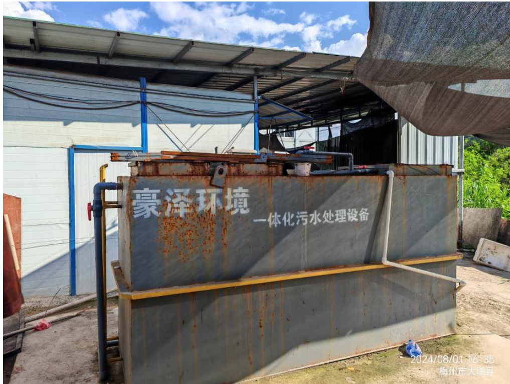
图5.1-1 生活污水一体化污水处理设备应用
