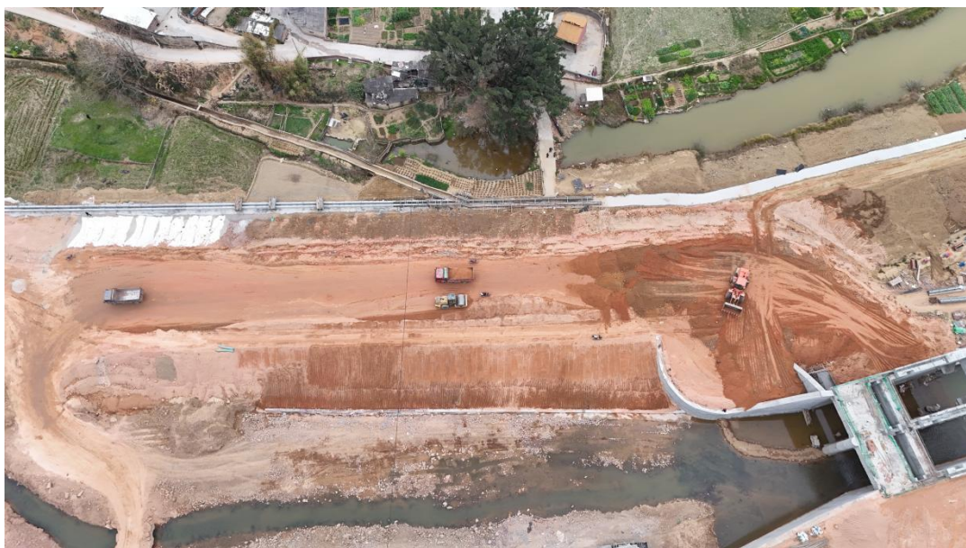
图5.1-13 小靖河堤防分层回填碾压照片
