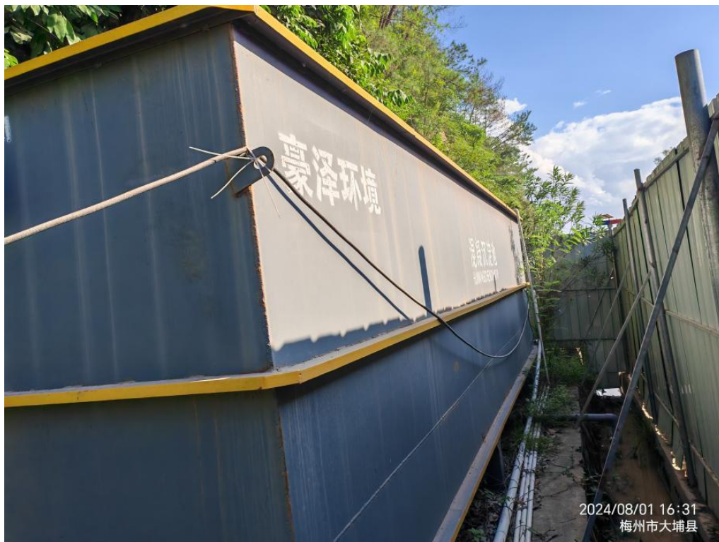
图5.1-2 施工污水一体化污水处理设备应用
